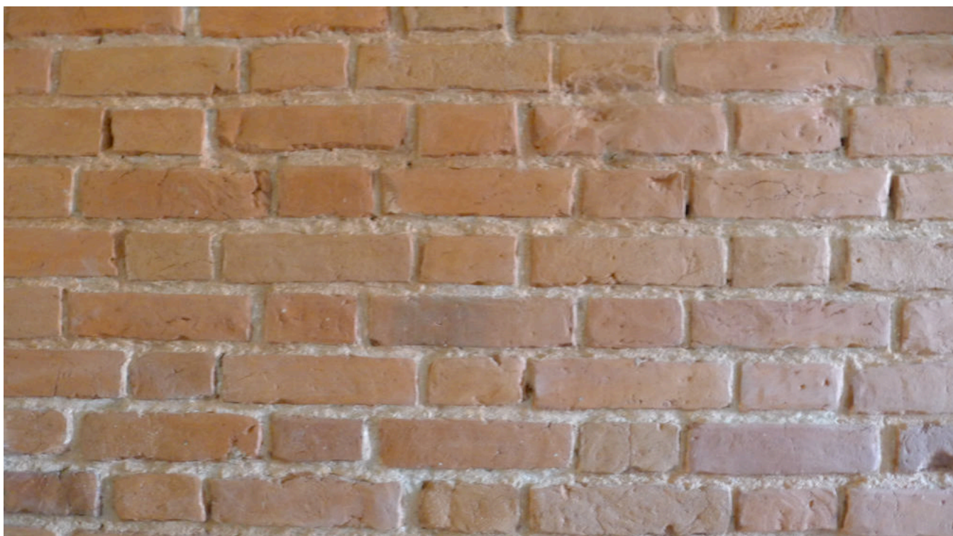
10. Фрагмент кладки стены продольного коридора 1-го этажа.
