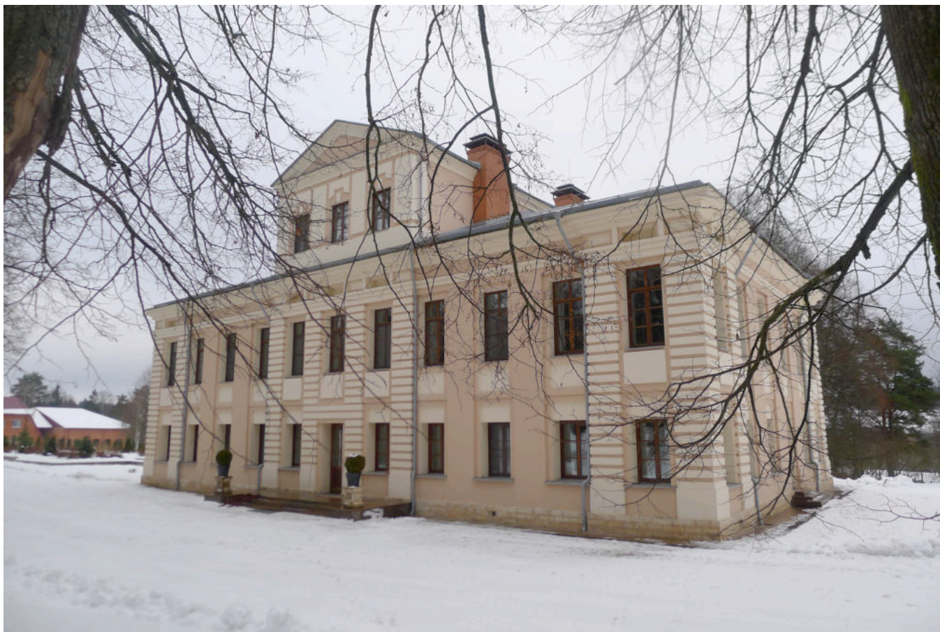
2. Вид с юго-запада.
