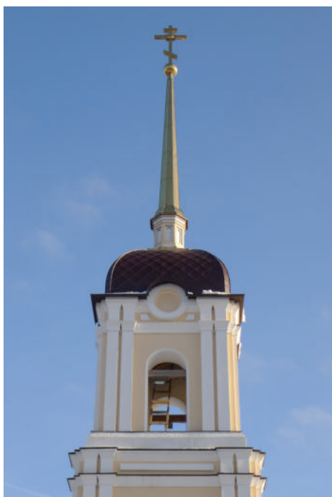
12. Фрагмент западного фасада колокольни.
