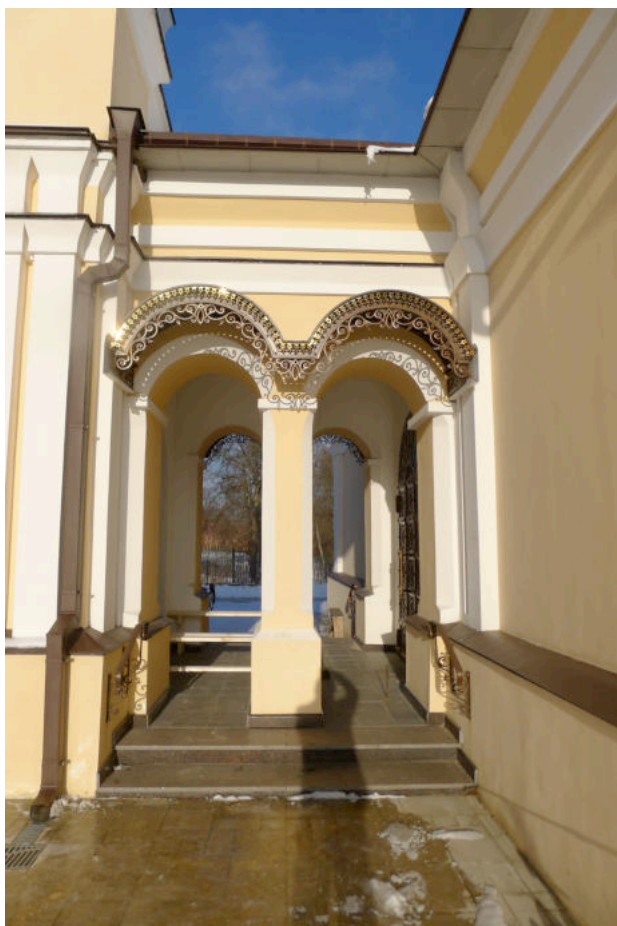
16. Переход от колокольни к трапезной. Южный фасад.
